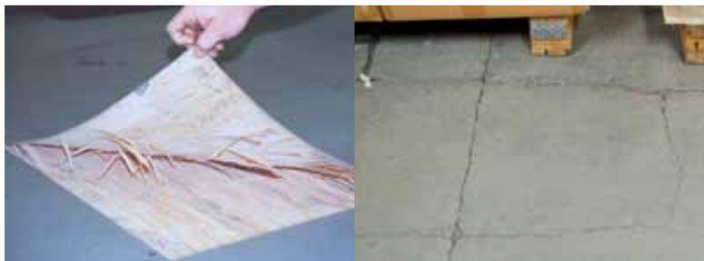
**Pisos com delaminação, rachaduras e descamação**
